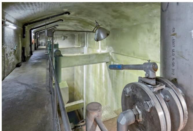
La camera d'espansione è uno spazio di ca. 28 x 6.5 m e alto 24 metri ricavato nella roccia e rivestito in calcestruzzo. Al suo interno le variazioni della portata di scarico delle turbine vengono smorzate, in seguito l'acqua defluisce verso il Lago Maggiore attraverso la galleria di restituzione.
