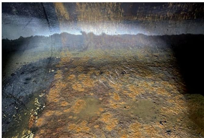
La condotta forzata adduce le acque dal bacino ai gruppi di produzione: è costruita in acciaio e inghisata in roccia all'interno di una galleria orizzontale e di un pozzo inclinato. Per evitare la corrosione e l'abrasione sulla superficie interna del metallo venne inizialmente applicata una protezione anticorrosione che con gli anni si è consumata e non garantisce più una protezione adeguata.
