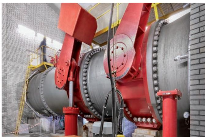
Le valvole di testa condotta sono installate in cima alla parte inclinata della condotta forzata. Esse vengono utilizzate per interrompere il flusso di acqua in caso di guasto alla centrale.
