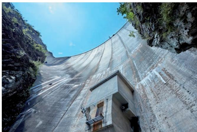
Lo scarico di fondo è un organo di sicurezza della diga, costituito da due paratoie, che funge da scarico dell'invaso in caso di necessità.
