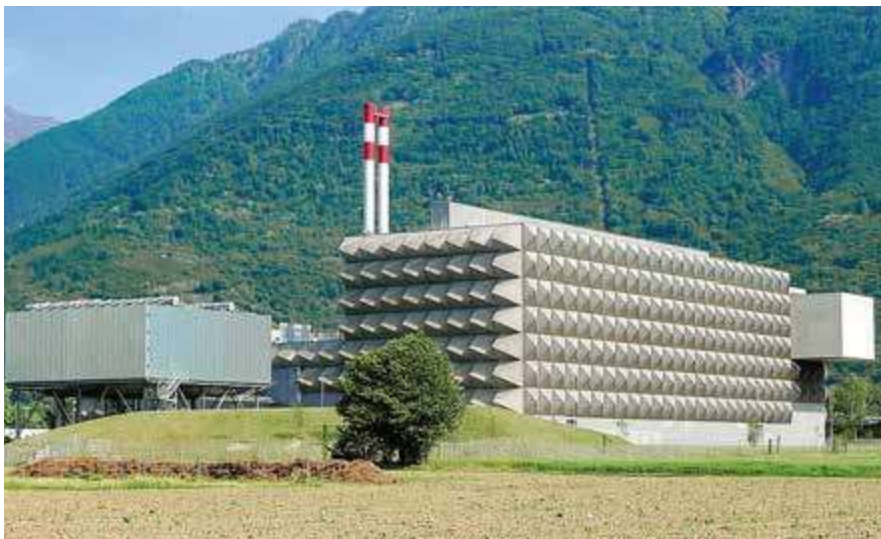
L'impianto di termovalorizzazione dei rifiuti di Giubiasco
